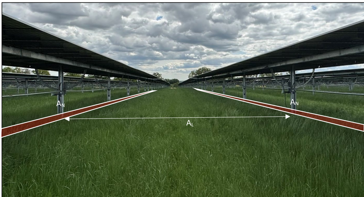
Abbildung 8: Beispiel einer Agri-PV-Anlage mit nachgeführten Horizontaltrackern in der Gemeinde Tütpatz, Vorhabenträger Vattenfall, Vorhabenstandort Tütpatz, Foto: Leddermann – Mai 2025
